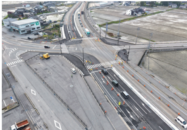
工事名／国道8号入善地区舗装その4工事 施工地／富山県下新川郡入善町
