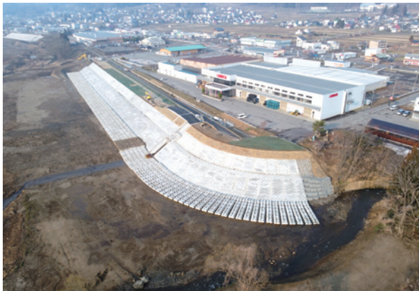
工事名／千曲川静間地区築堤護岸他その2工事 施工地／長野県飯山市
