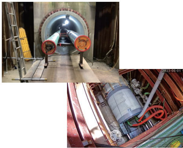
工事名／東京ライン・松本ライン東御市海野地内 復旧工事の内導管工事 施工地／長野県東御市
