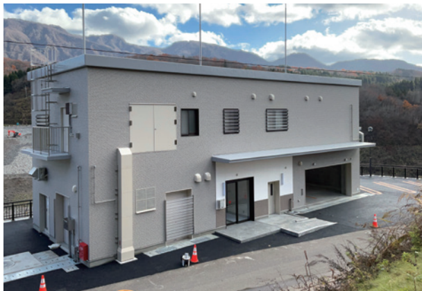
工事名／鵜川ダム管理所建築工事 施工地／新潟県柏崎市
