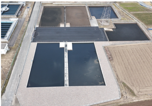
工事名／二系天日乾燥床築造第三期工事 施工地／新潟県新潟市
