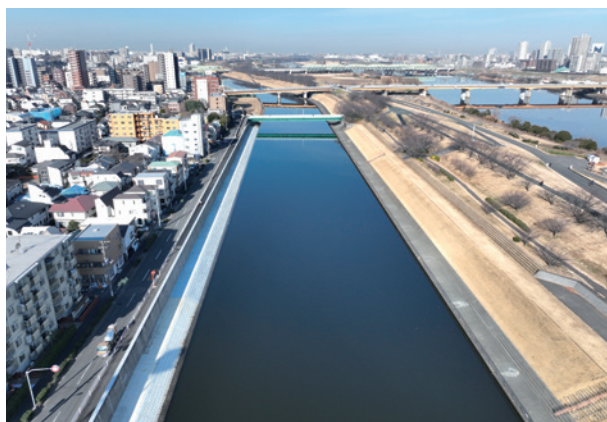
工事名／新河岸川防潮堤耐震補強工事(その5) 施工地／東京都北区
