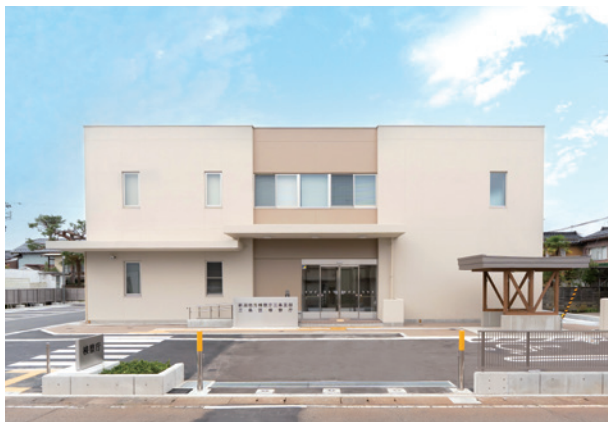
工事名／新潟地方検察庁三条支部(23)新築工事 施工地／新潟県三条市
