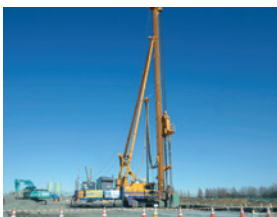
▲遠隔操作室から大型地盤改良機を操作
