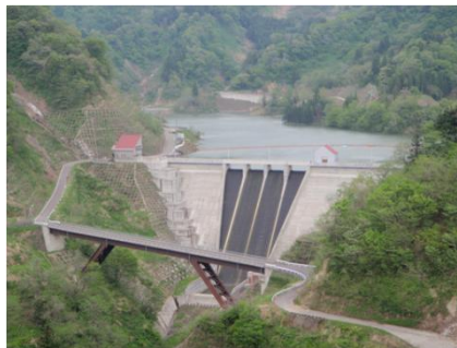
土木工事(ダム)
