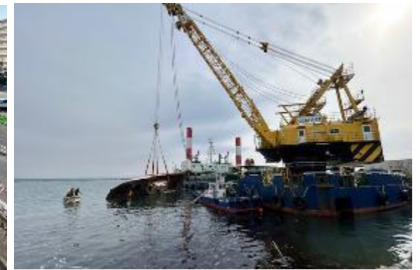
能登地震での沈没船引き揚げ (石川県珠洲市 飯田港)
