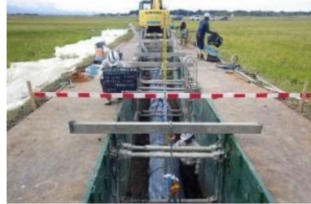
水道管の耐震化工事
