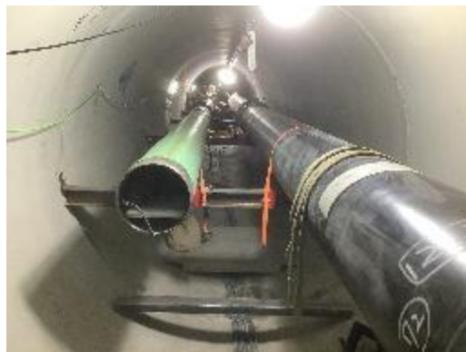
ガスパイプライン敷設工事
