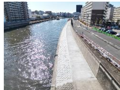
新河岸川防潮堤耐震補強工事 (東京都)
