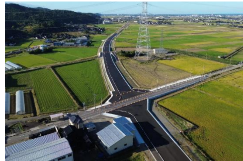
道路舗装工事
