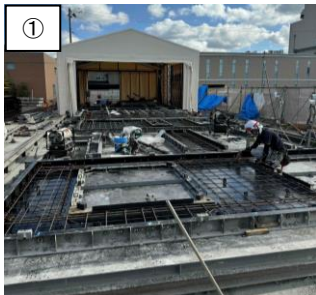
現場内で PC 部材を ①製作、②ストック、③組み立てる様子
