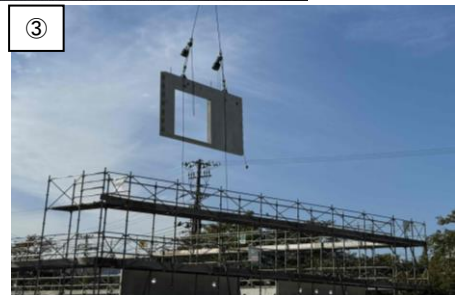
現場内で PC 部材を ①製作、②ストック、③組み立てる様子
