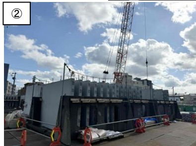
現場内で PC 部材を ①製作、②ストック、③組み立てる様子
